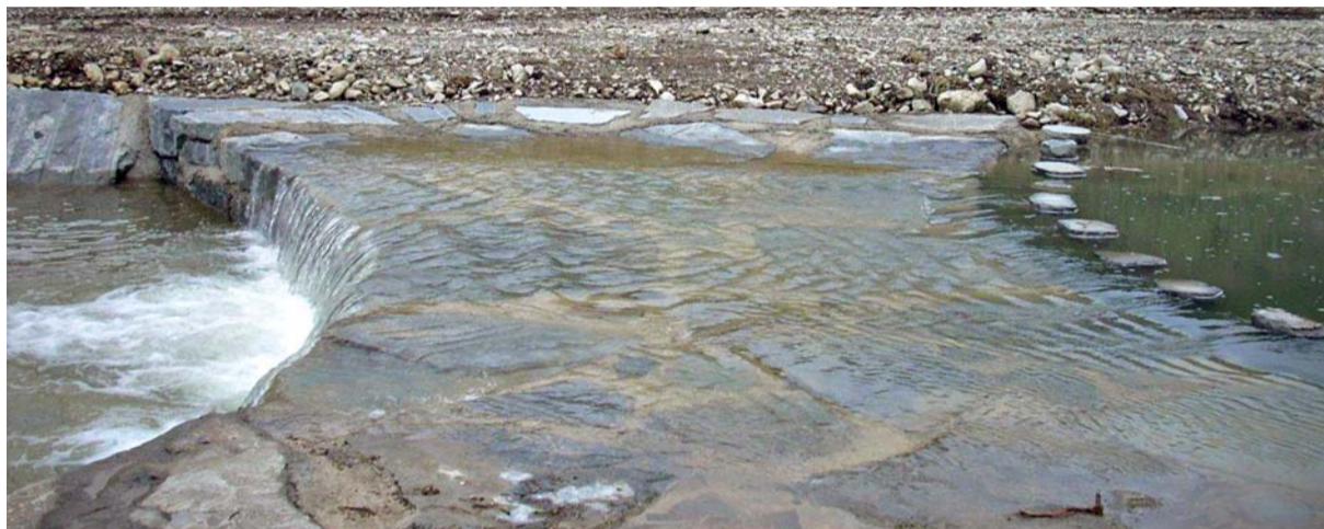
Dopo: la soglia completata e suoi effetti sull'ossigenazione delle acque
