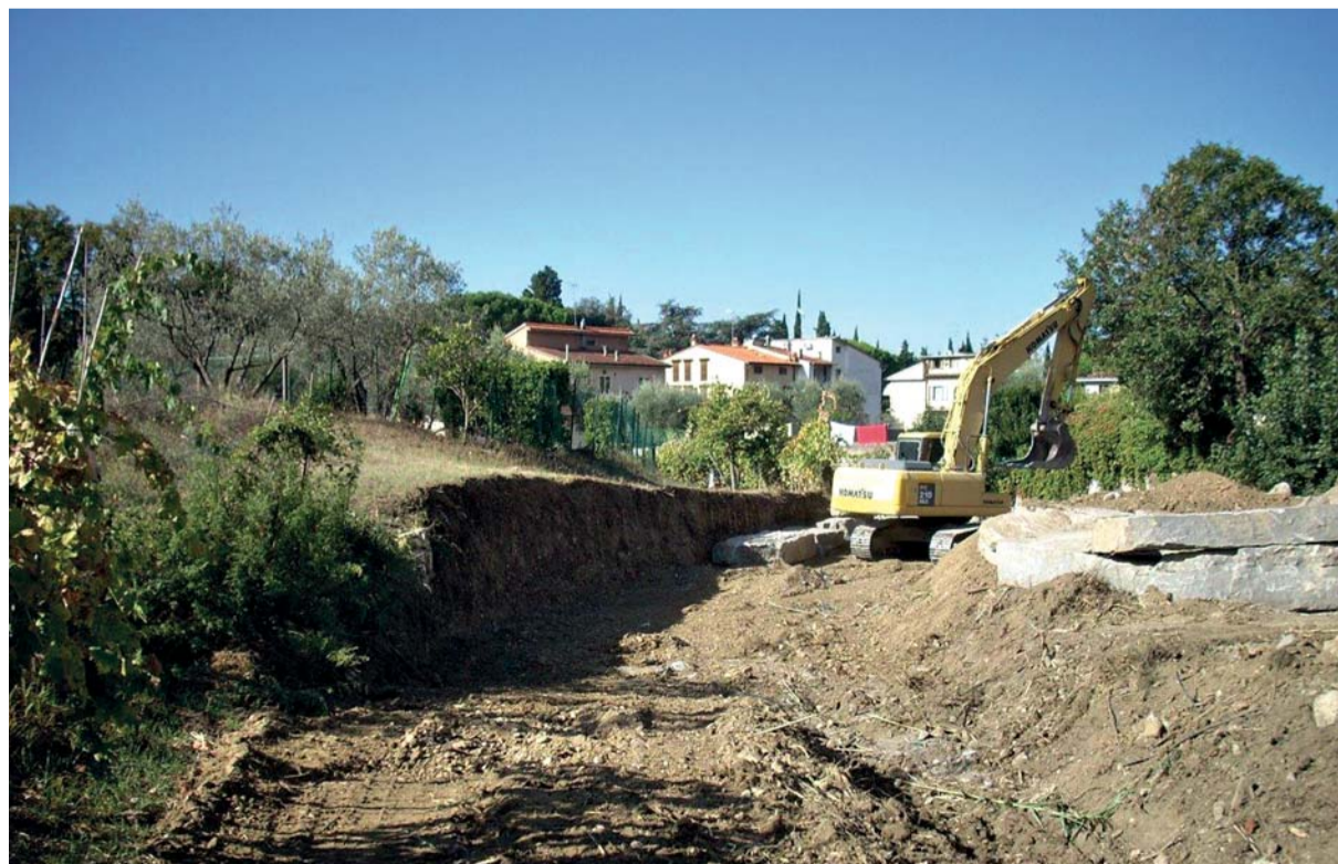
Due immagini dei lavori sullo Zambra
