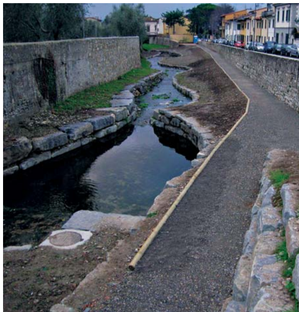
Un'immagine dei lavori sul Rimaggio
