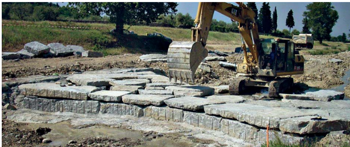
Prima: le operazioni di costruzione della nuova soglia
