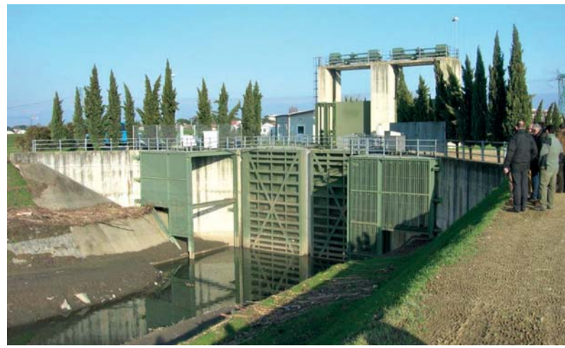
Le paratoie sul Fosso Reale sulle quali è stata collocata la webcam che permette di controllare in diretta il livello del Bisenzio
