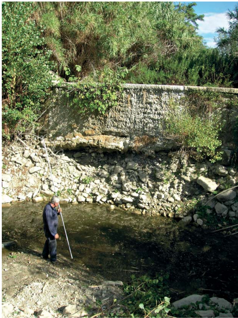
La briglia in località Sant'Andrea a Sveglia, sul Mugnone, prima dei lavori
