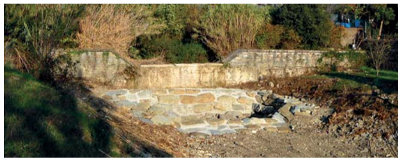
La stessa briglia dopo la conclusione dei lavori
